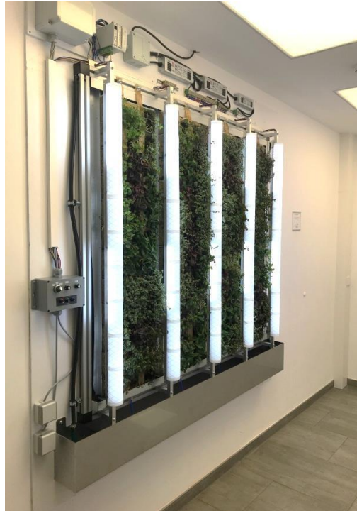
Demonstrator des autonomen Living-Wall-Systems mit geöffneter Blende
