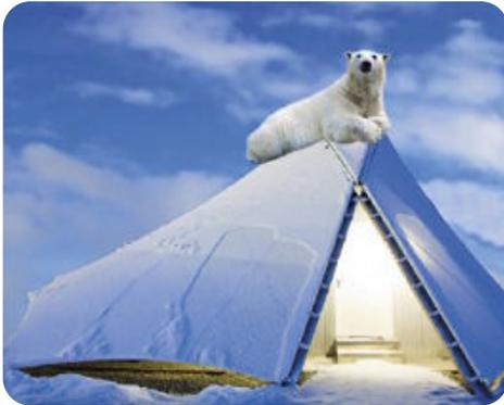
für Textil- und Verfahrenstechnik (ITV) in Denkendorf. Der energieautarke Pavillon zur ganzjährigen Nutzung besitzt neuartige textile Solarkollektoren aus mehreren Membranschichten, die eine hohe Wärmeisolation aufweisen. Vorbild dafür ist das Funktionsprinzip, das die Textiler der Natur – in diesem Fall dem Eisbärfell – abgeschaut haben: Einfallendes Sonnenlicht trifft auf ein schwarz be-
