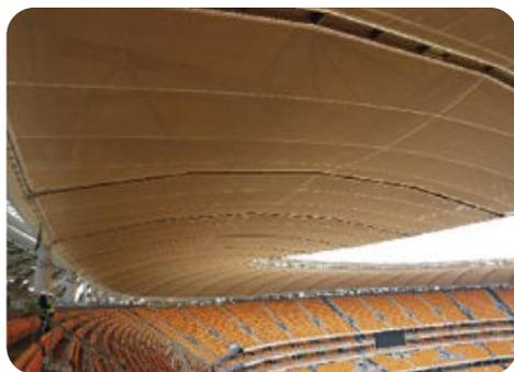
Innenausbau) auf Grün. Textil ist neben Stein, Holz, Metall und Glas der fünfte Baustoff. Textile Architektur nutzt Flächen aus Fasermaterial als Vorhang, Schirm, Dach, Zelt oder Luftblasen (pneumatische Bauten wie Traglufthallen, begehbare Pavillons) – und inzwischen auch als Stahlersatz im Beton. Das Kolosseum in Rom mit seinen 23.000 Quadratmetern Abschattungsfläche war die erste antike Ikone des textilen Membranbaus; heute überspannen be-
